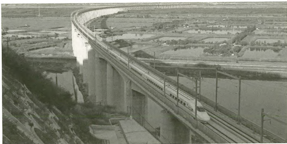
黄河高铁第一桥
