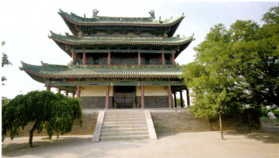
大荔县岱祠岑楼
