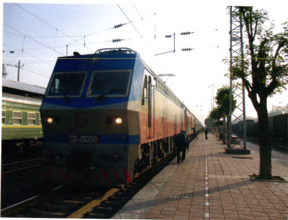
陇海铁路渭南段电气化列车
