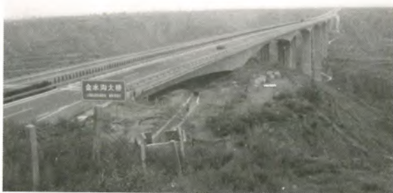
华夏第一公路高桥——金水沟大桥
