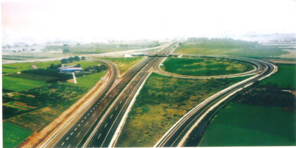
西潼高速公路渭南西入口
