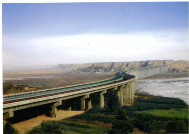
西禹高速韩城芝川大桥
