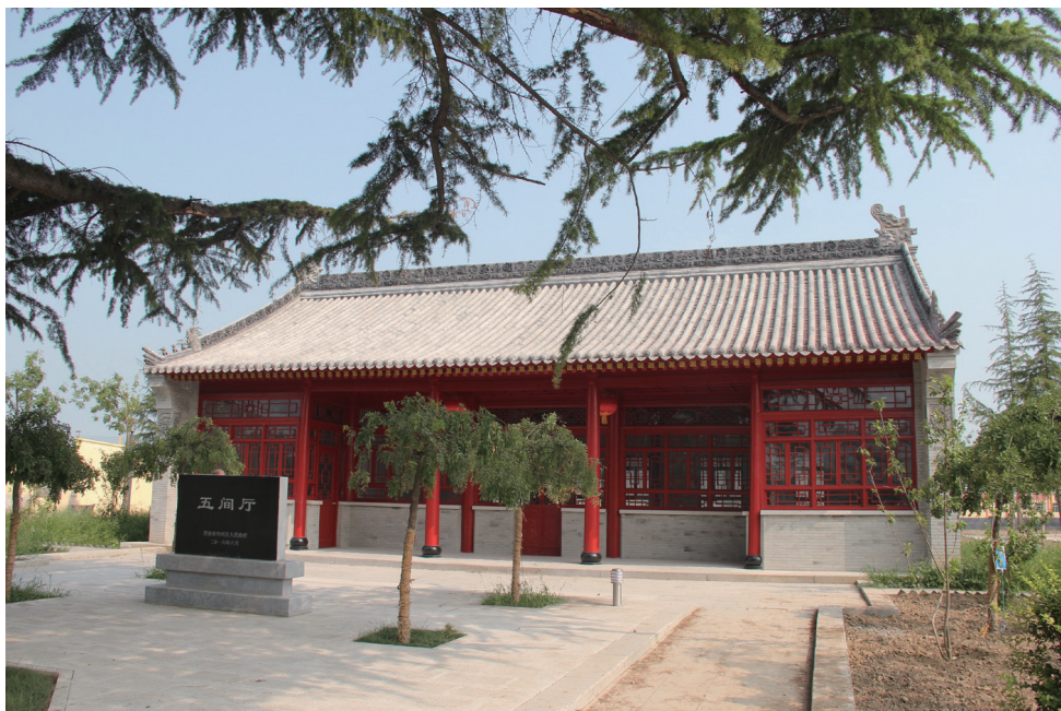
修缮后的五间厅
