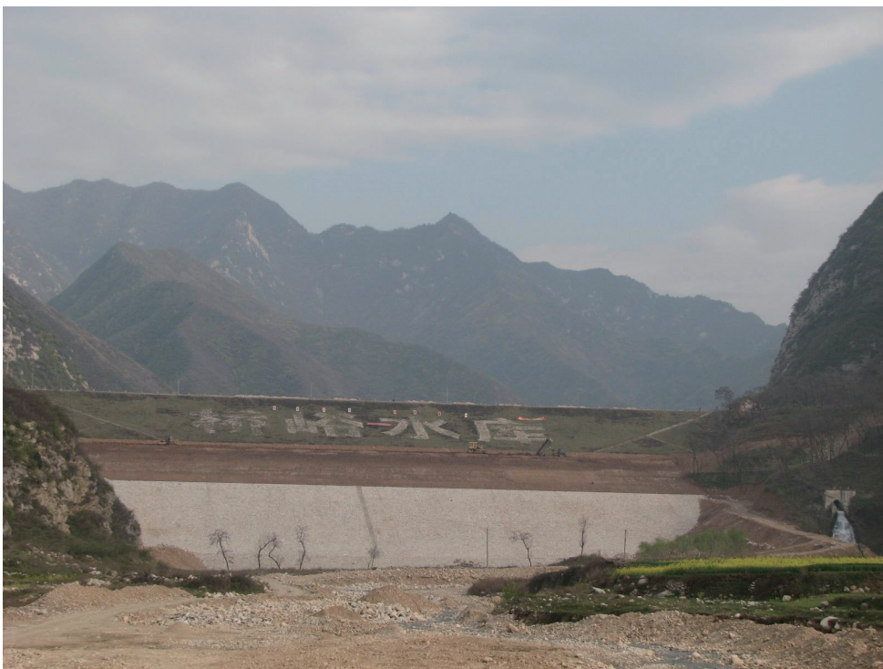
桥峪水库大坝
